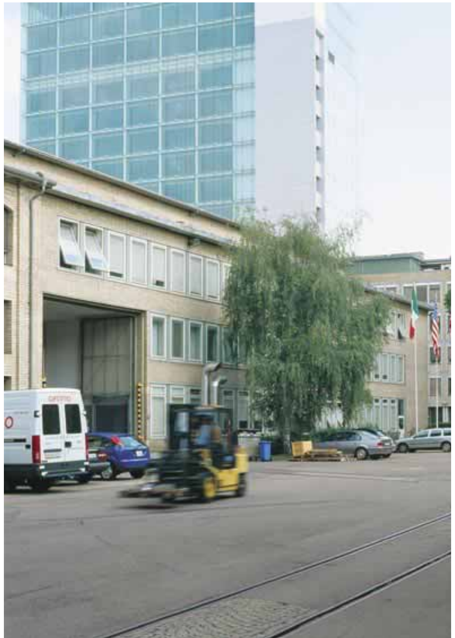
3 Blick von der Rückfassade des Wohlfahrts- hauses in die Eisenbahn-Durchfahrt der Fabrikhalle. Hinten das Mobimo-Hochhaus.
